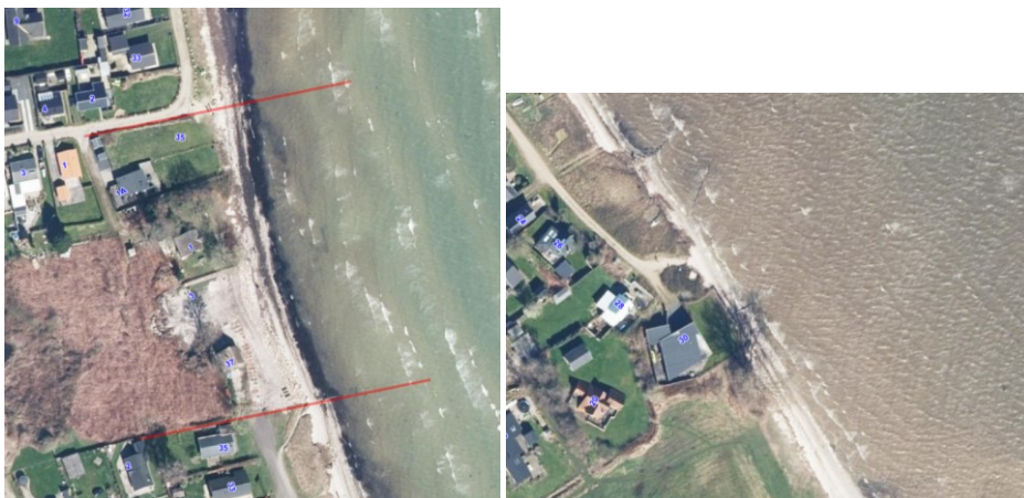
Figur 2: Strækning med lidt plads til diget. Venstre foto viser Bakkevej mod nord og Strandvej mod syd. Højre foto viser det sydligste hus, Strandvejen Grønninghoved 30
